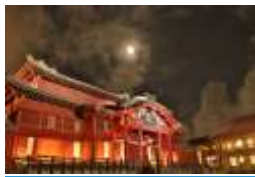
図VI-29 首里城正殿 夜のライトアップ
