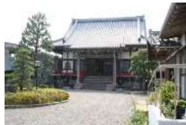
図8-14 いわき市 菩提院 境内の様子
